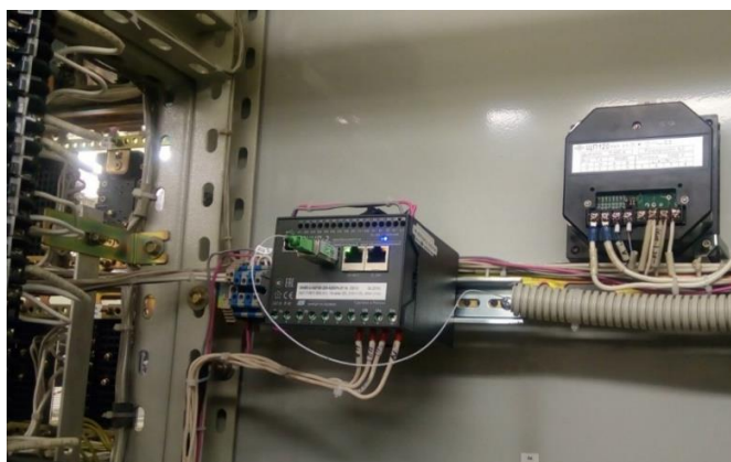
Рис. 7. Контроллер ЭНИП-2 с поддержкой технологии GPON
